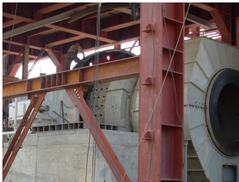
نصب و راه اندازی گیربکس برای آسیاب غلطکی
